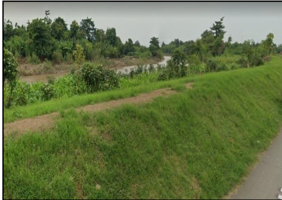
Pembuatan tanggul di Desa Tengki Tengah Brebes untuk mengatasi luapan Sungai Pemali
