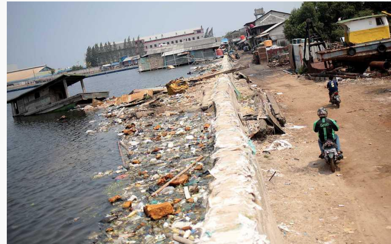
Penurunan tanah di Pluit-Jakarta Utara, serta upaya penanggulangan dengan membuat Giant Sea Wall disepanjang pantai
