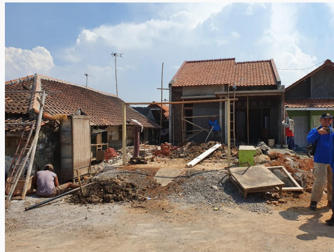
Upaya mitigasi yang dilakukan penduduk, Pekalongan dengan meninggikan permukaan tanah
