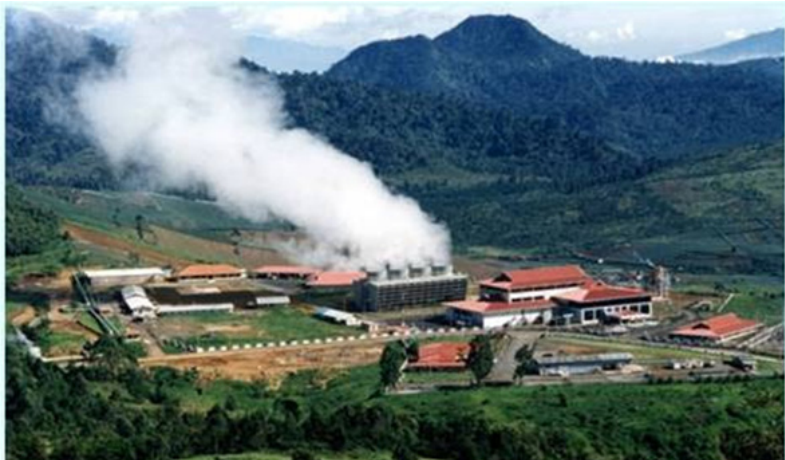
Gambar 5.14. Keadaan Kompleks Panas Bumi Darajat, Kabupaten Garut setelah selesainya peningkatan Unit III pada tahun 2009, total kapasitas daya listrik PLTP Darajat naik dua kali lipat menjadi 271 MW, (sumber: https://www.starenergygeothermal.co.id/ )
